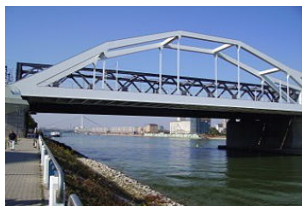
Puente fabricado de acero
